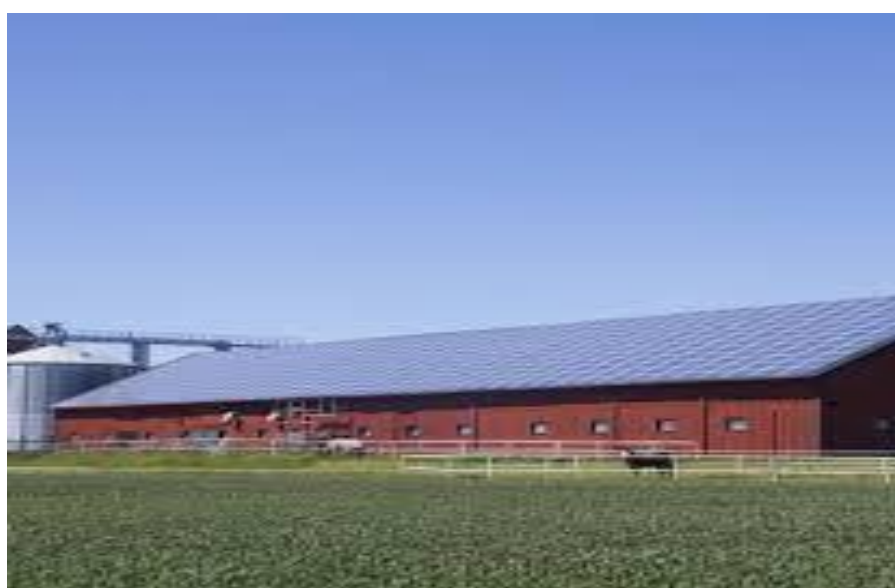
Budynek produkcyjny w całości pokryty panelami fotowoltaicznymi
