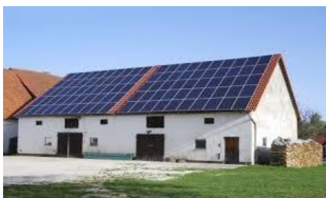
Zaadoptowany dach na potrzebę paneli fotowoltaicznych
