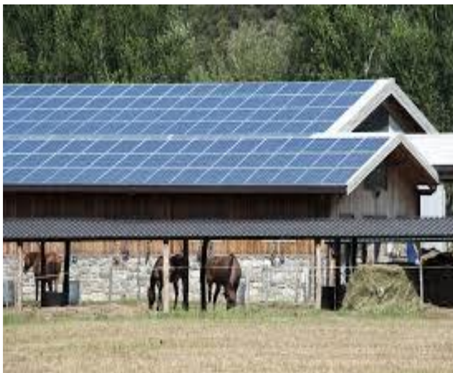
Panele fotowoltaiczne na budynkach rolnych
